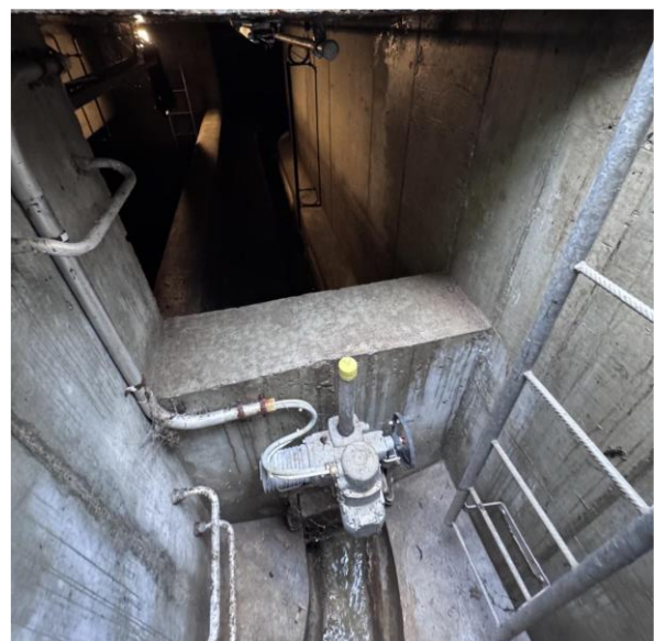
Abbildung 10: Schieberschacht
