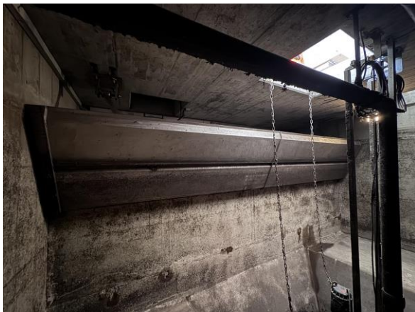
Abbildung 13: Überfallkante Entlastungskanal
