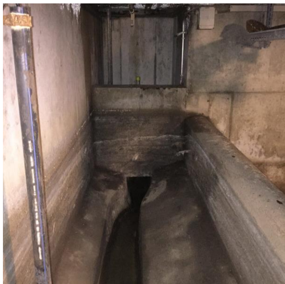
Abbildung 9: Einlaufkanal mit Überfallkante
