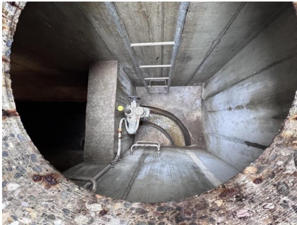
Abbildung 11: Schieberschacht
