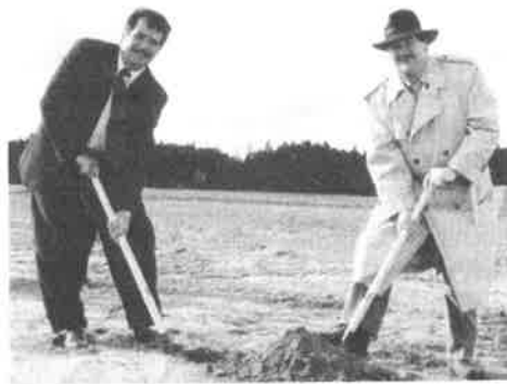
Spatenstich durch die Talot-Präsidenten Peter und Roland Suter
