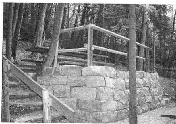
Die obere Terrasse wurde durch eine neue Stützmauer gesichert.
